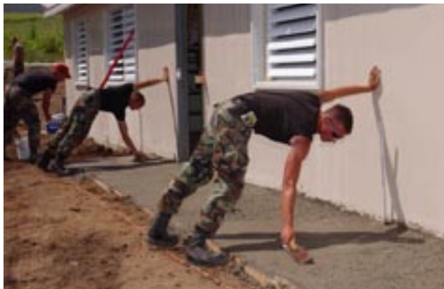
Американские военные инженеры выравнивают цементную пешеходную дорожку возле медицинского центра в Сент-Китсе и Невисе, федерации островов в Карибском море. Подразделения Армейской национальной гвардии, ВВС, Армейского резерва и Корпуса морской пехоты работали вместе с Оборонительными силами Сент-Китса и Невиса при проведении учений «Новые горизонты» в 2003 году. (Фото старшего авиатехника Мишеля Дж. Мизиано, ВВС США)
